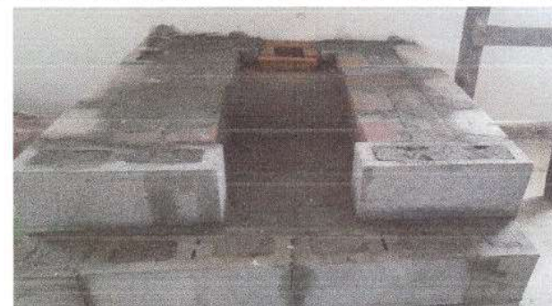
Foto 4: Sustitución de estufa rural (incluye chimenea y plancha de metal) en modulo cocina.
