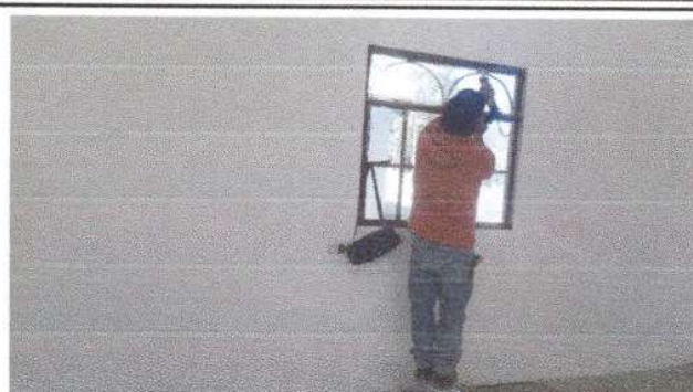
Foto 2: Sustitucion de ventana de madera por metal mas vidrio en modulo de cocina
