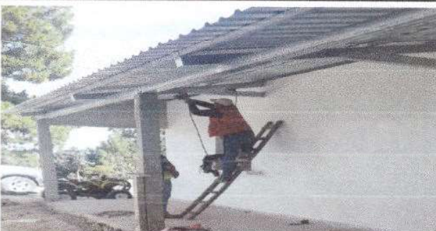
Foto 6: Sustitucion ducto electrico y accesorios en modulo cocina
