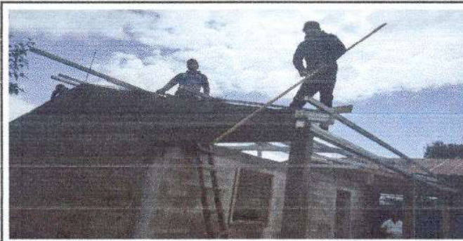
Foto 6: Instalación de estructura de portante de metal en modulo cocina.
