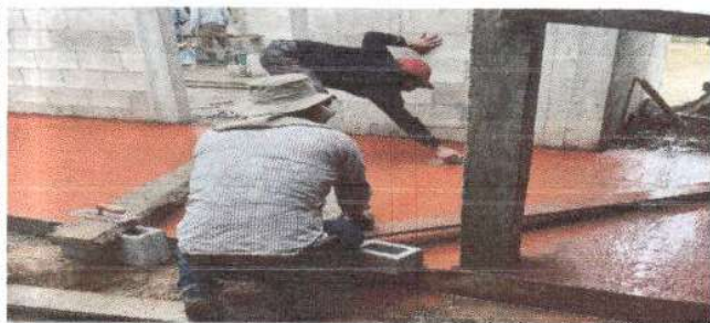
Foto 3: Sustitucion de piso de torta de concreto en modulo de cocina.
