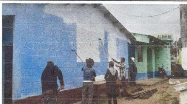
Foto 4: Pintura en muros exteriores en modulo de aulas.
