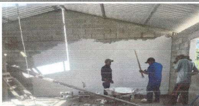
Foto 5: Repello en muro interior en modulo cocina
