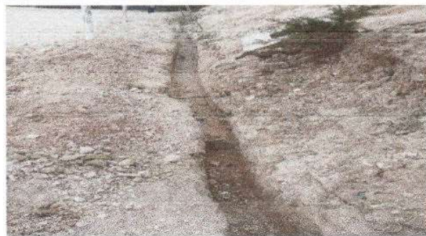
Foto 2: Instalación de tubería para agua potable en modulo cocina.
