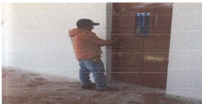
Foto 1: Fabricación e instalación de puerta de metal en modulo cocina
